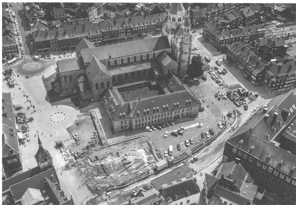
Vue aérienne de la Grand-Place de Nivelles durant les travaux en 2010 (photo : G. Focant © SPW/DG04)
